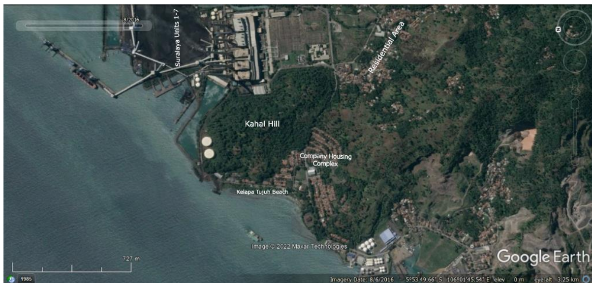
Sebelum dimulainya konstruksi PLTU Jawa 9 dan 10 (Juni 2016).
