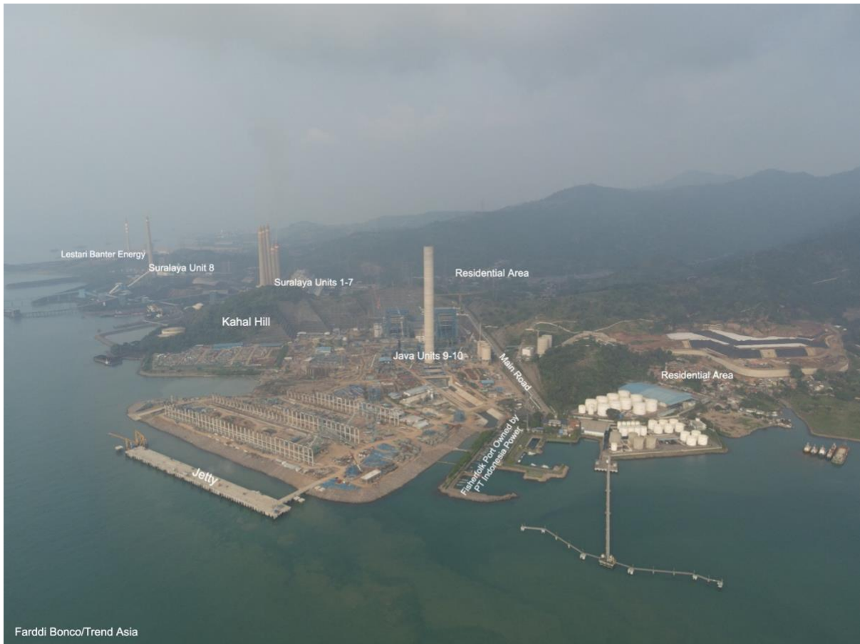
Pembangunan sebagian PLTU Jawa 9 dan 10 (Juli 2023).
